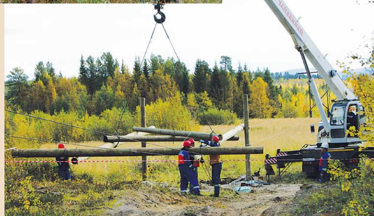
▲ Подготовка к установке П-образной опоры условно поврежденной линии 110 кВ в Кандалакшском районе Карелии
