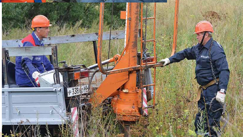
▲ Подготовка к установке П-образной опоры условно поврежденной линии 110 кВ в Кандалакшском районе Карелии
